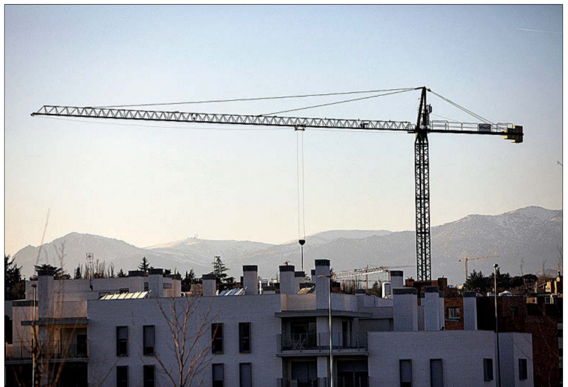
Construcción de una promoción de viviendas en Colmenar Viejo, en Madrid. ALBERTO DI LOLLÍ
